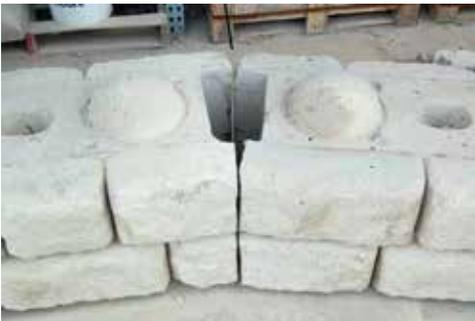
Farbiger Schaumstoff „Backer Rod“ kann verwendet werden, um kleine Lücken zu füllen, die beim Einbau von Wänden zwischen den Blöcken entstehen können. Backer Rod kann in Betonfachgeschäften erworben werden. Wenden Sie sich an Ihren Redi-Rock Hersteller vor Ort, wenn Sie Hilfe bei der Suche nach Schaumstoffdichtungsbändern für Ihr Projekt benötigen.
