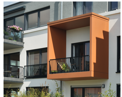
Objekt: Frankenhauser „Bauen und Wohnen“, Biberach
