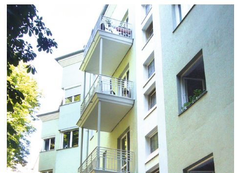
Objekt: Nachträgliche montierter Betonfertigteilbalkon am Sanierungsobjekt Prinzregentenstraße, München
