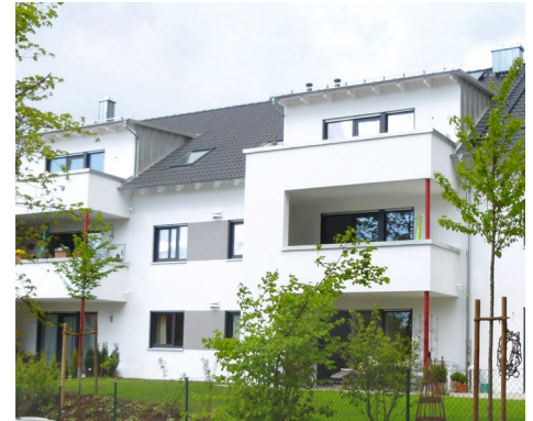
Objekt: Objekt Wohnanlage Lenzfried; Architekturbüro Steinhauser Ottobeuren; mit Stahlstützen
