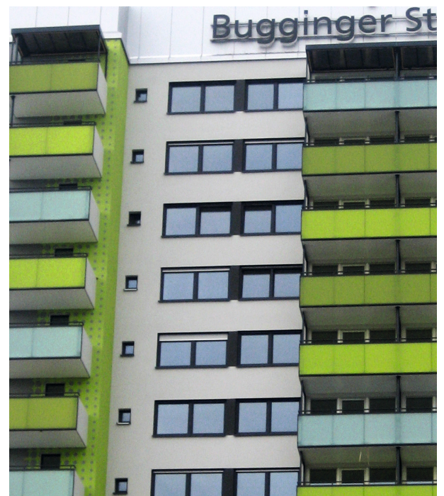
Objekt: Fertiggelände, Sanierungsobjekt: Bugginger Straße, Freiburg
