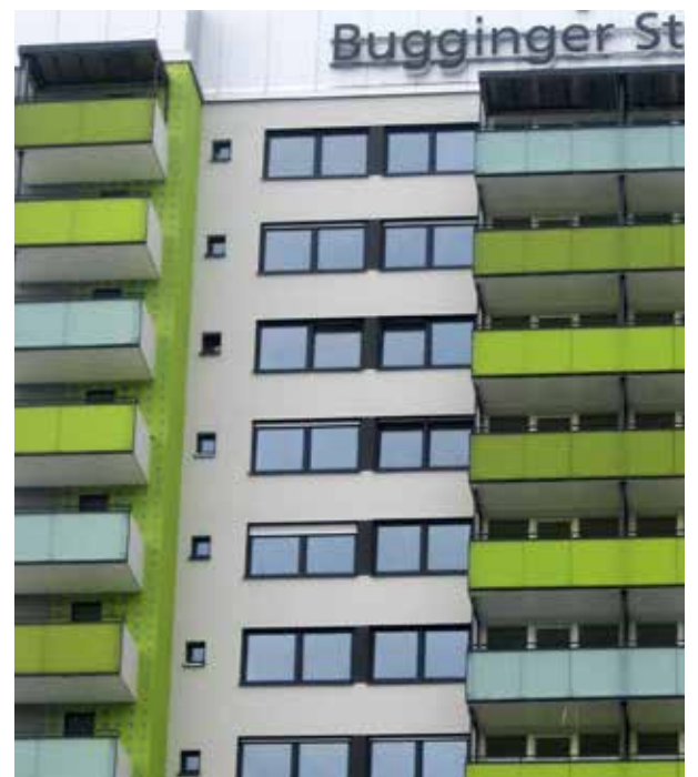
Objekt: Fertiggelände, Sanierungsobjekt: Bugginger Straße, Freiburg
