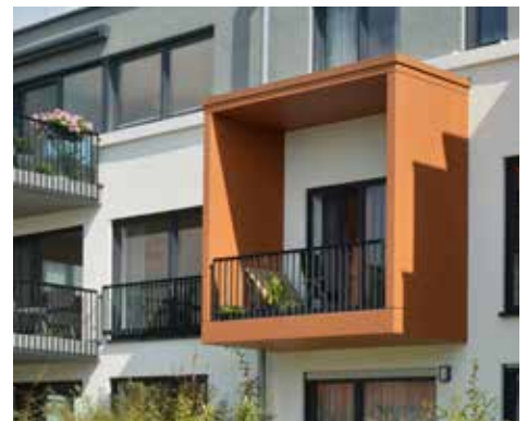
Objekt: Frankenhauser „Bauen und Wohnen“, Biberach
