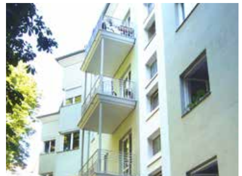
Objekt: Nachträglich montierter Betonfertigteilebalkon am Sanierungsobjekt Prinzregentenstraße, München
