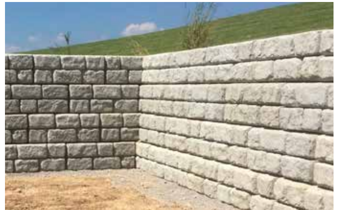
Abb.: Stützwandsystem in Blocksteinoptik mit Innenecke
