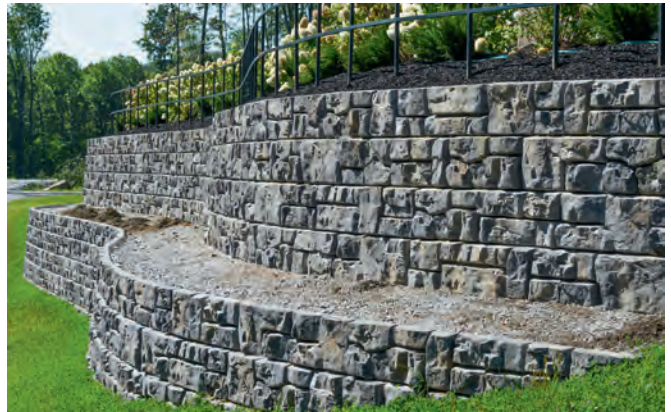
Abb.: Stützwandssystem in Felssteinoptik mit Rundungen
