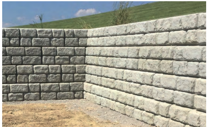
Abb.: Stützwandssystem in Blocksteinoptik mit Innenecke
